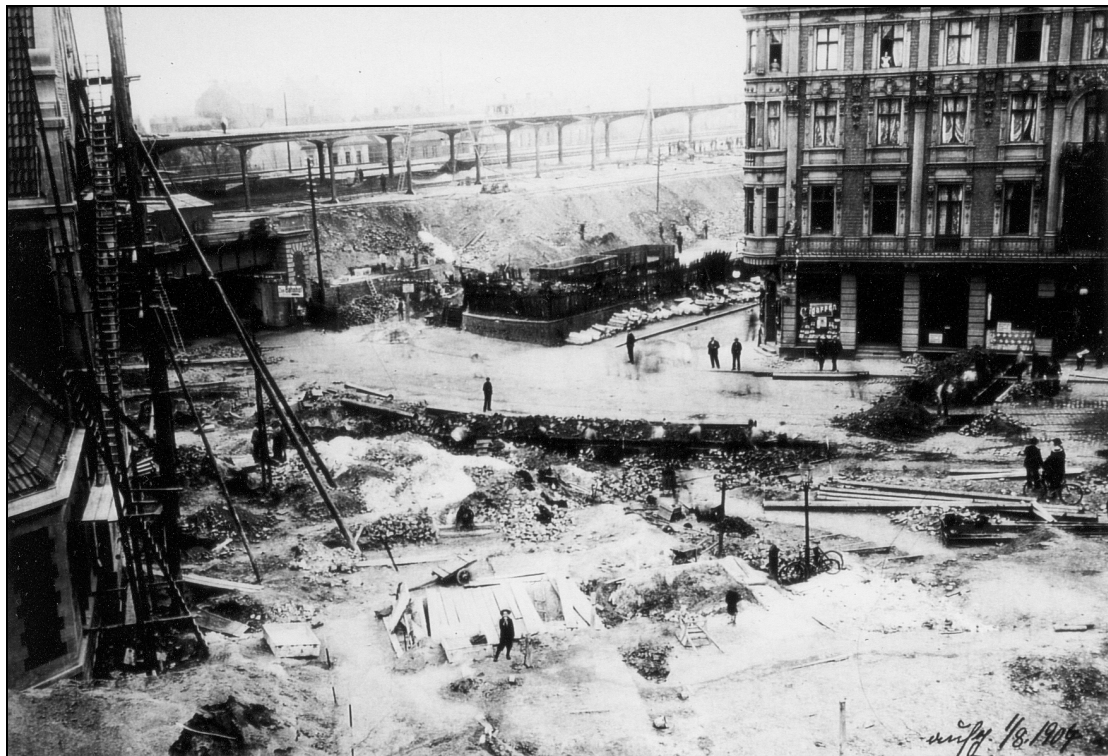
Abb. 13: Baustelle Bahnhofsgelände und Umfeld am 1. August 1904
