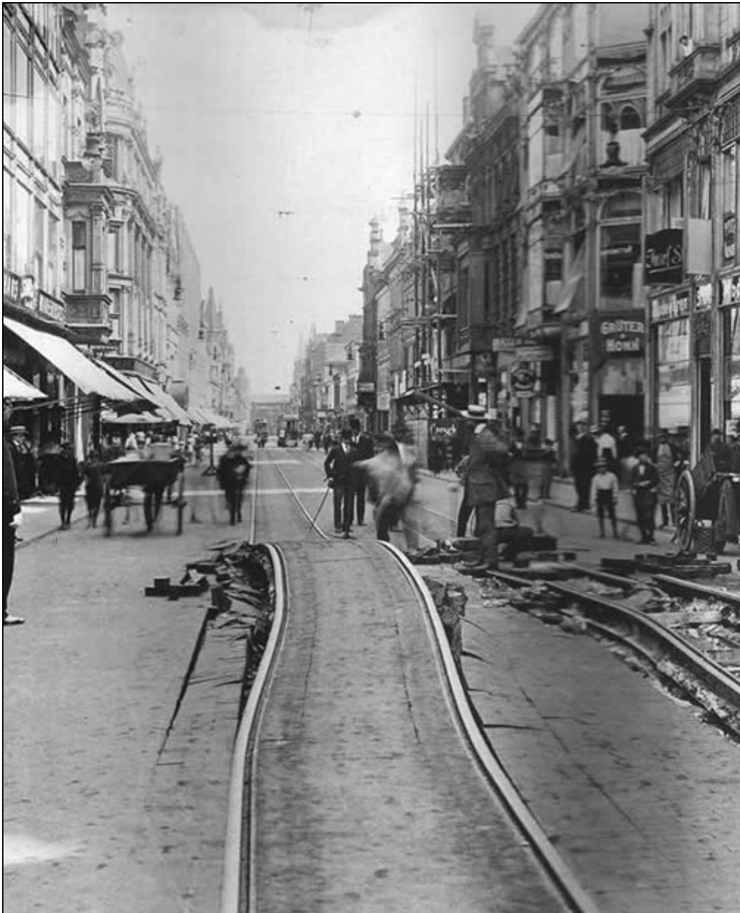
Abb. 12: Straßenbahnschienenverwerfung auf der Bahnhofstraße im heißen Sommer 1914.
