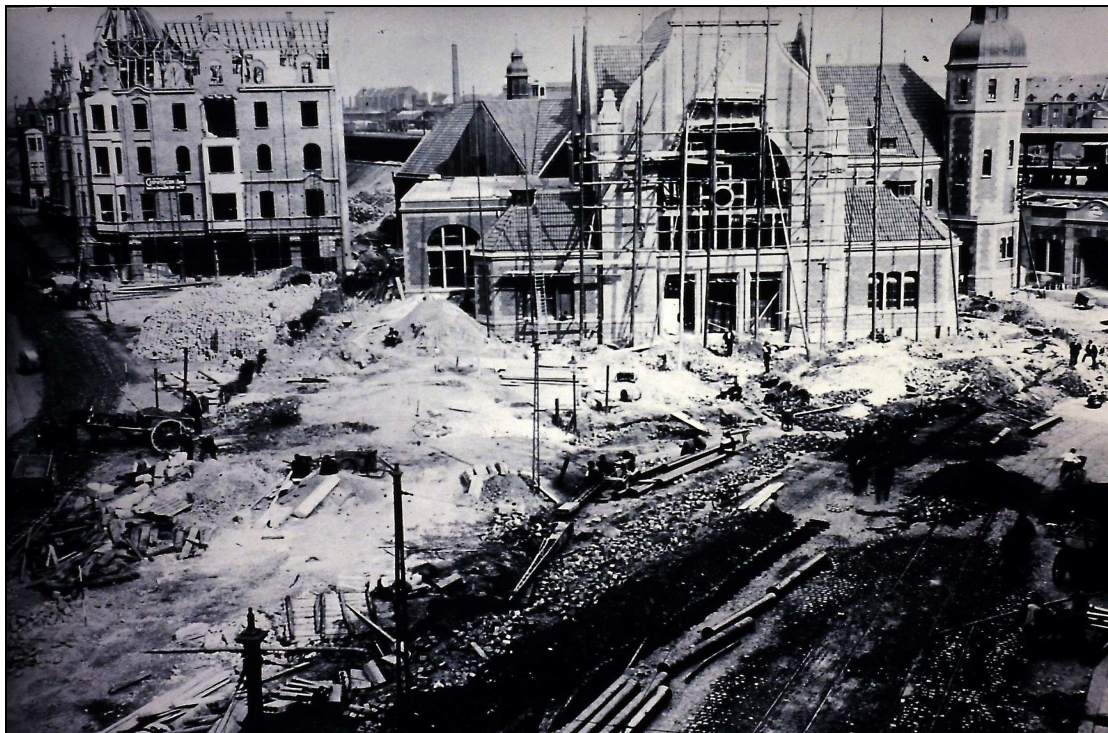
Abb. 18: Im Bau befindliches Bahnhofsgebäude sowie Umgestaltung des Vorplatzes 1. August 1904
